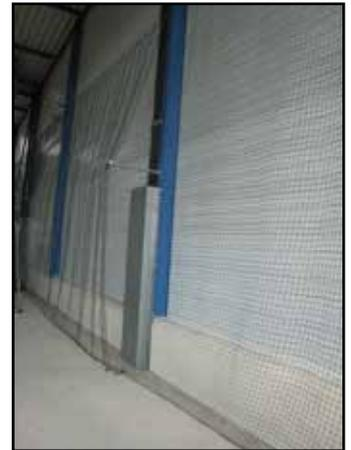
**Filet pare ballons** avec consoles pour maintenir un déport permettant de protéger les murs fragiles. Permet aussi d'éviter un niveau sonore élevé lors des tirs sur les panneaux métalliques. S/D
