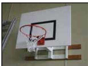
Mise en place sur supports existants avec haubans fixés sur la charpente.
